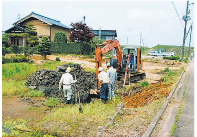
馬越遺跡周辺地 1 トレンチ調査風景（東から）
