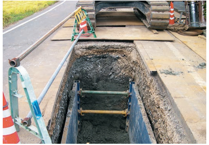
花立遺跡 調査風景 (南東から)
