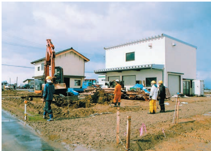
中沢遺跡 1 トレンチ調査風景（北東から）
