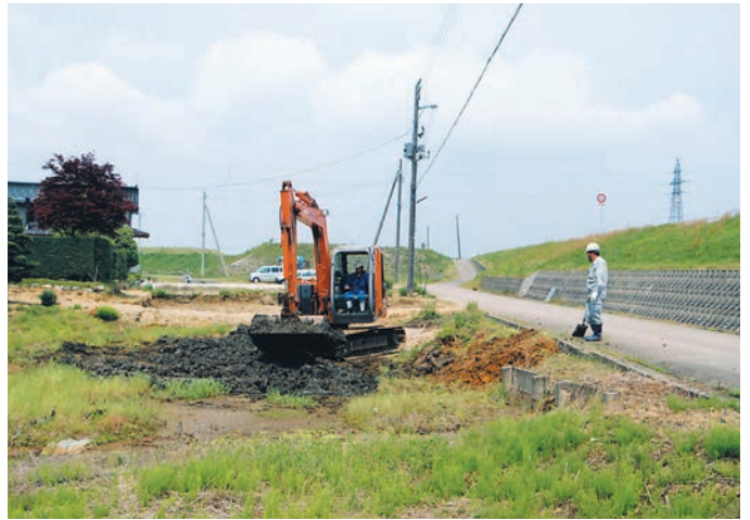
馬越遺跡周辺地 1 トレンチ埋め戻し風景（東から）
