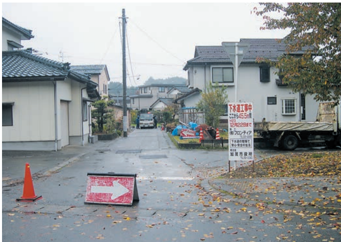
舞台遺跡 調査地近景（北から）
