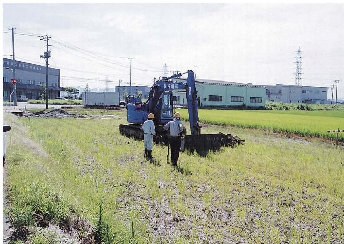
後須田地区 調査風景 (北西から)
