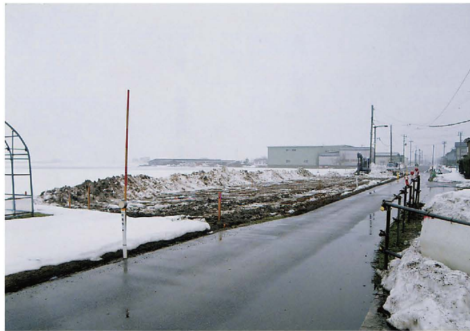
中沢遺跡 道路建設区調査前状況（南から）
