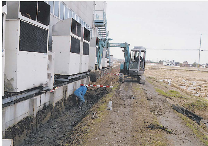
中沢遺跡 排水路改良区調査風景（北から）
