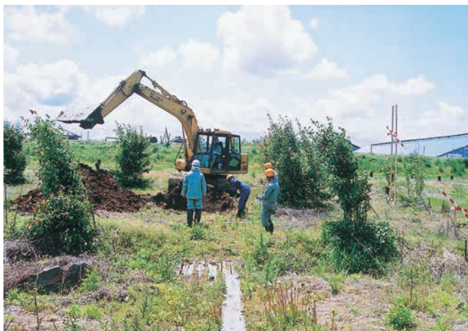
加茂新田地区 22 トレンチ調査風景 (北から)
