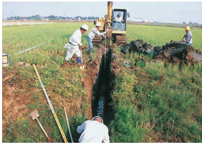
西吉津川遺跡 調査風景 (南から)
