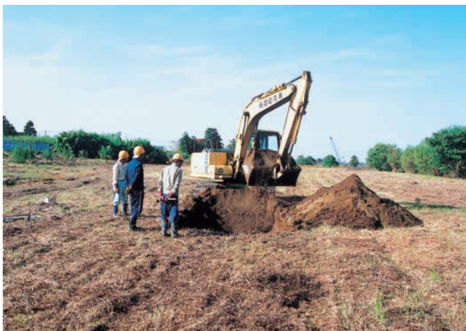
加茂新田地区 32 トレンチ調査風景 (北東から)
