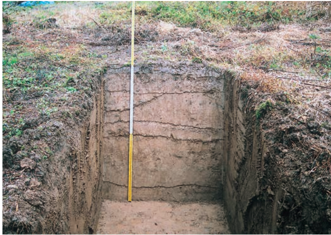
加茂新田地区 26 トレンチ土層断面 (西から)
