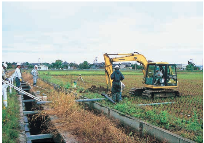
西吉津川遺跡 調査風景 (南西から)
