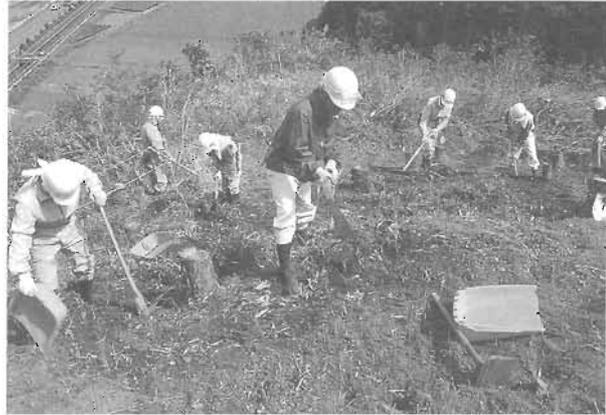
写真5 表土除去作業状況
