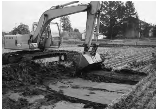
重機稼動状況
