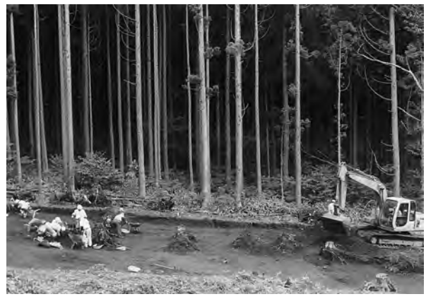
重機稼動状況
