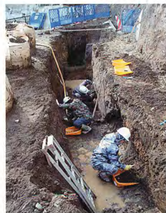
調査のようす 排水しながらの掘削と実測作業
