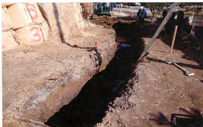
確認調査(擁壁設置範囲) 新たに3基の横穴が発見された
