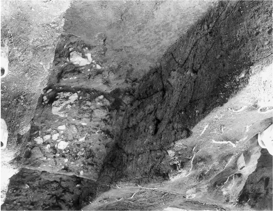
堀切門跡17トレンチ域壁（南東から）
