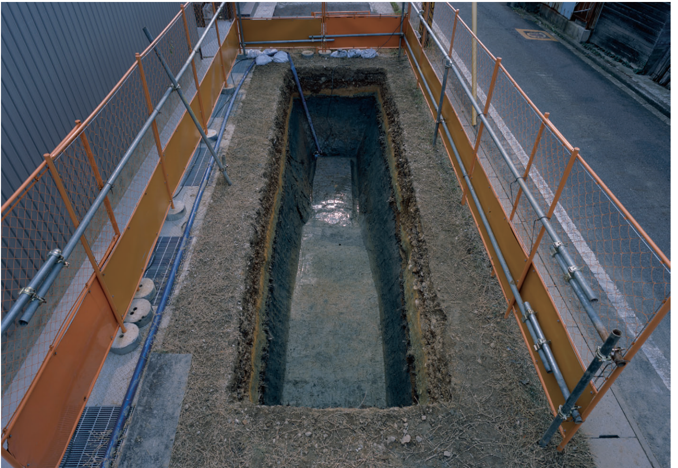
写真33 2区全景 完掘状況 -北から-
