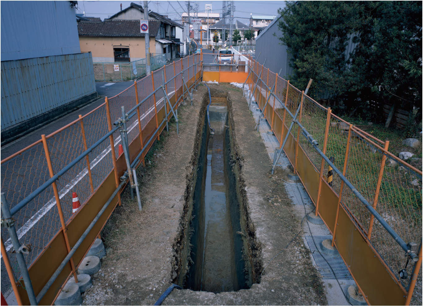
写真32 1区全景 完掘状況 -南から-
