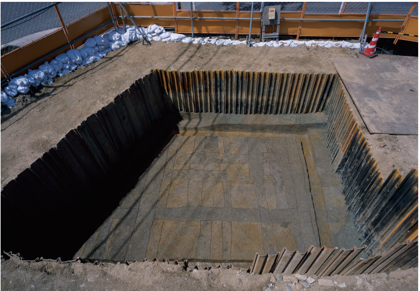
写真16 南区全景 上層遺構検出状況 -東から-
