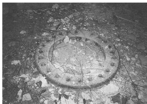
亀島砲台跡 砲座 (平成6年12月5日撮影)
