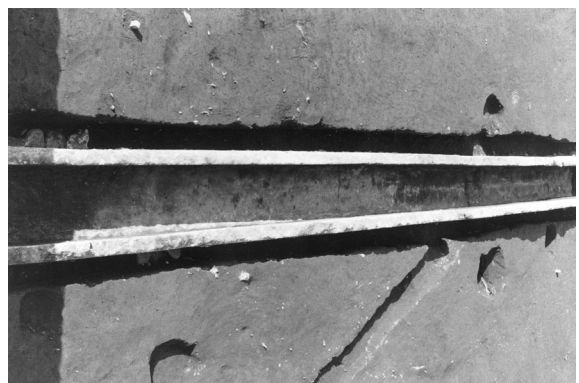
図版58 コンクリート製排水構 (東から)
