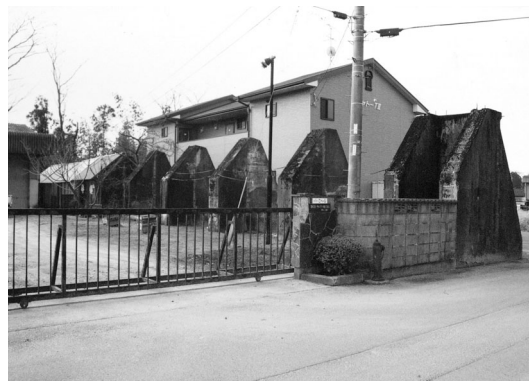
木造格納庫跡
