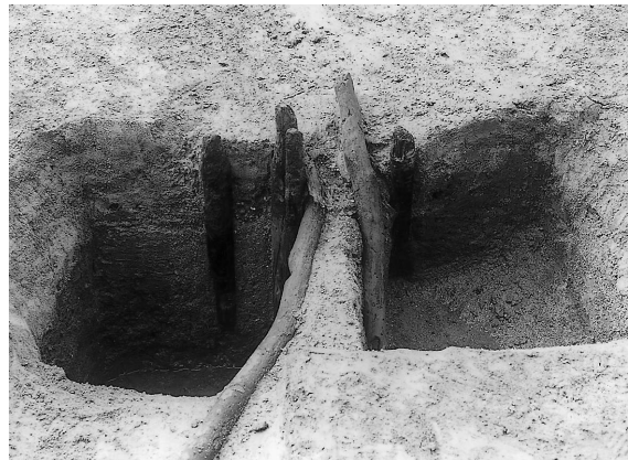
16. SW28～32断面 北東から
