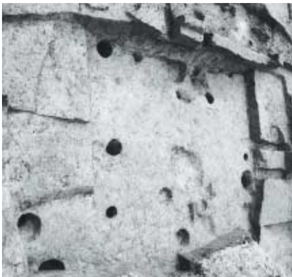
5 8号竪穴住居跡南側ベッド部除去後状況
