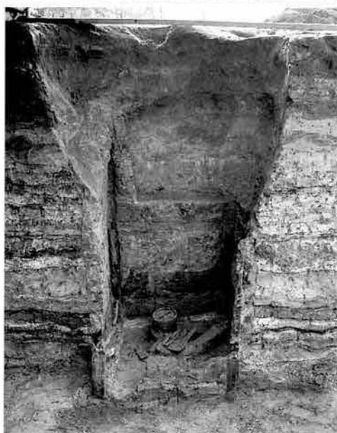
左：SK24 右：SK24断面
