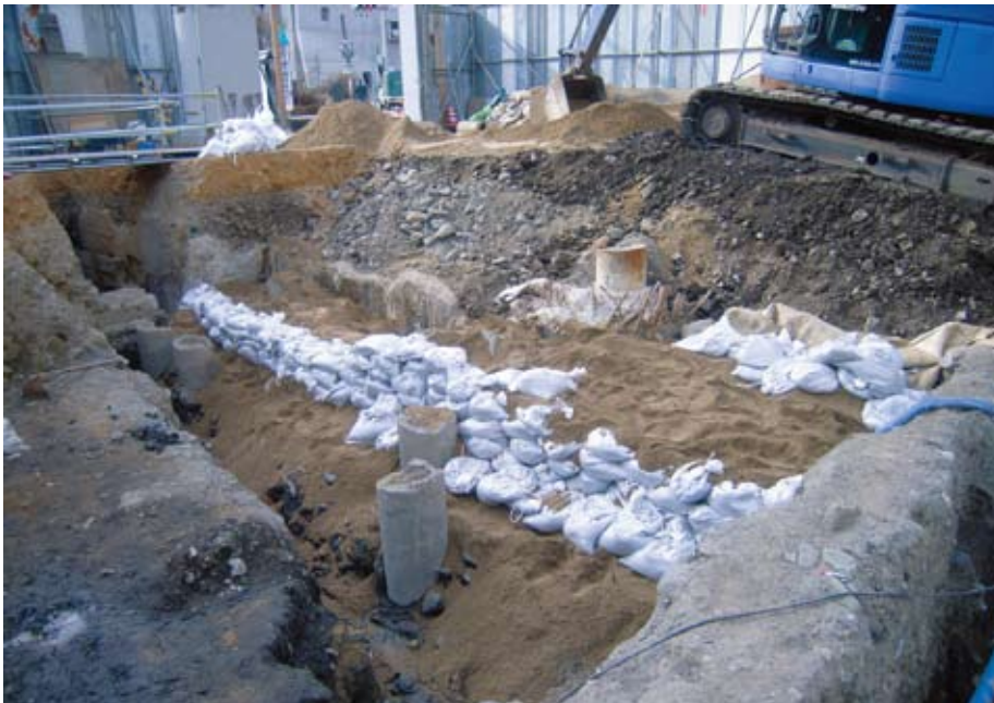
埋め戻し状況
