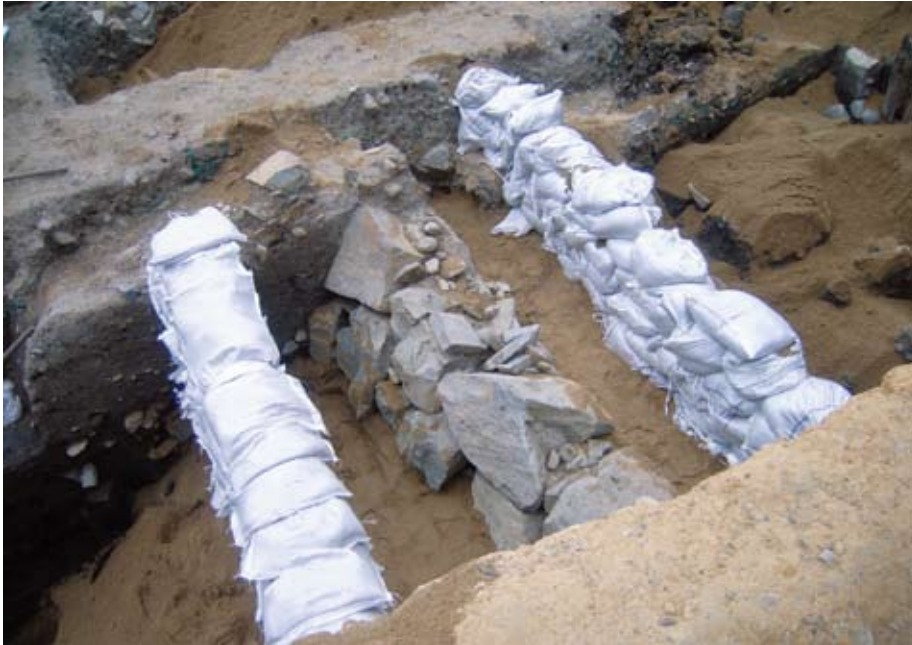
埋め戻し状況
