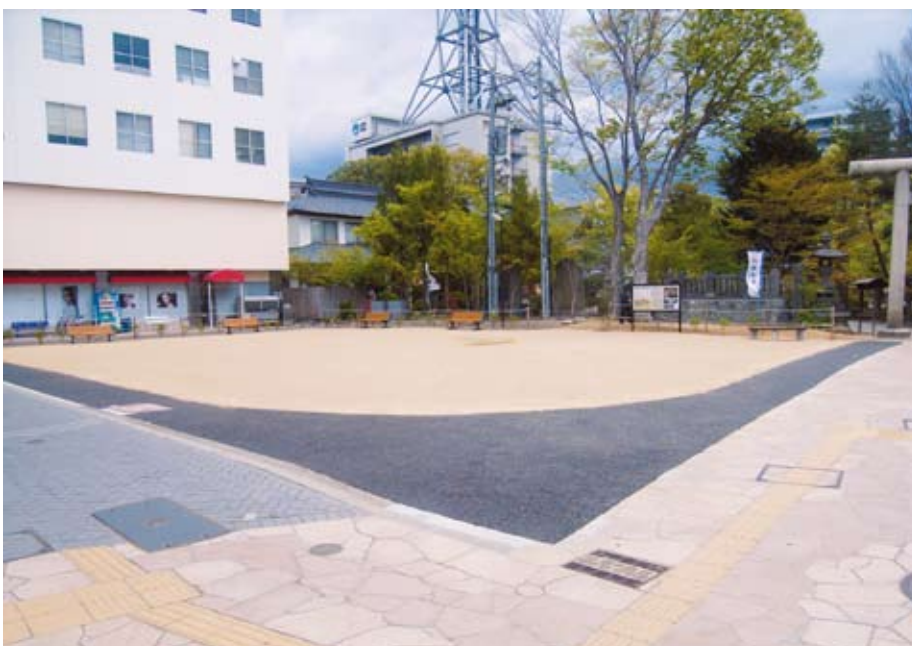
松本城大手門枳形跡広場の整備状況
