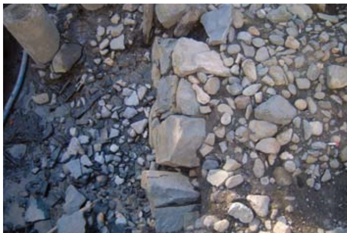
写真18 南区北端 石垣根固め (北から)
