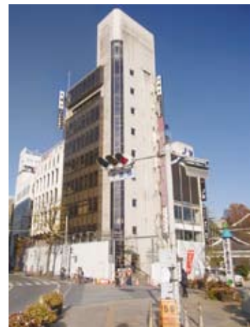
写真1 解体されるビル
