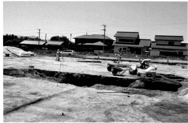
平成25年度基準杭設定作業・調査風景1（北から）
