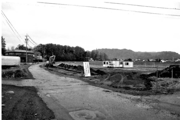
平成24年度表土除去作業（南から）
