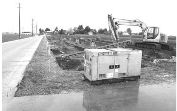
ベルコン設置 北から
