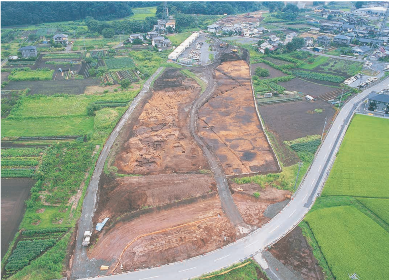
3区（左側）完掘状況と4区（右側）検出状況（南より）
