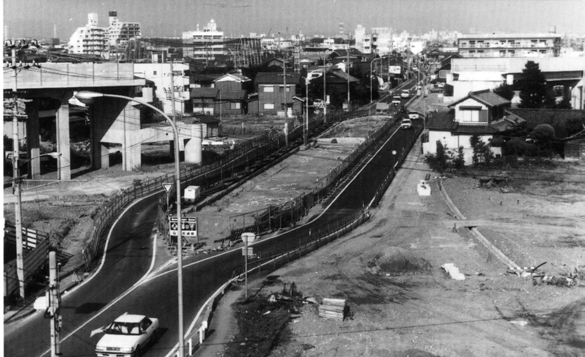
62A区全景 (南西から)
