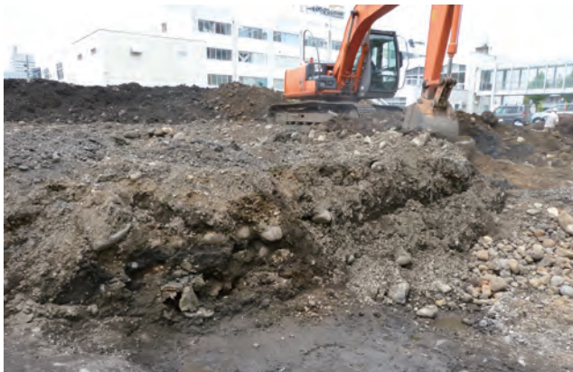
第39図 重機による表土掘削状況 (北から)
