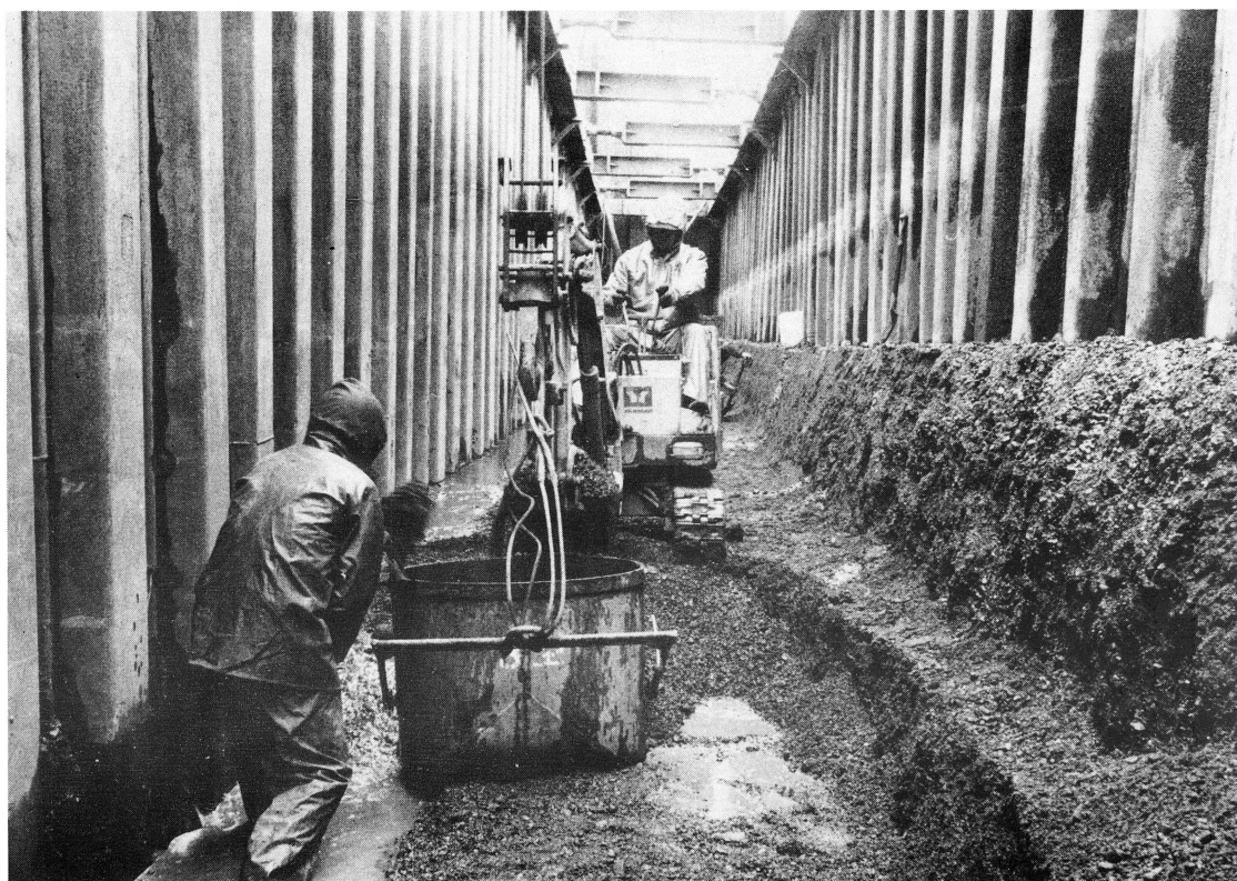
2. 表土掘削状況
