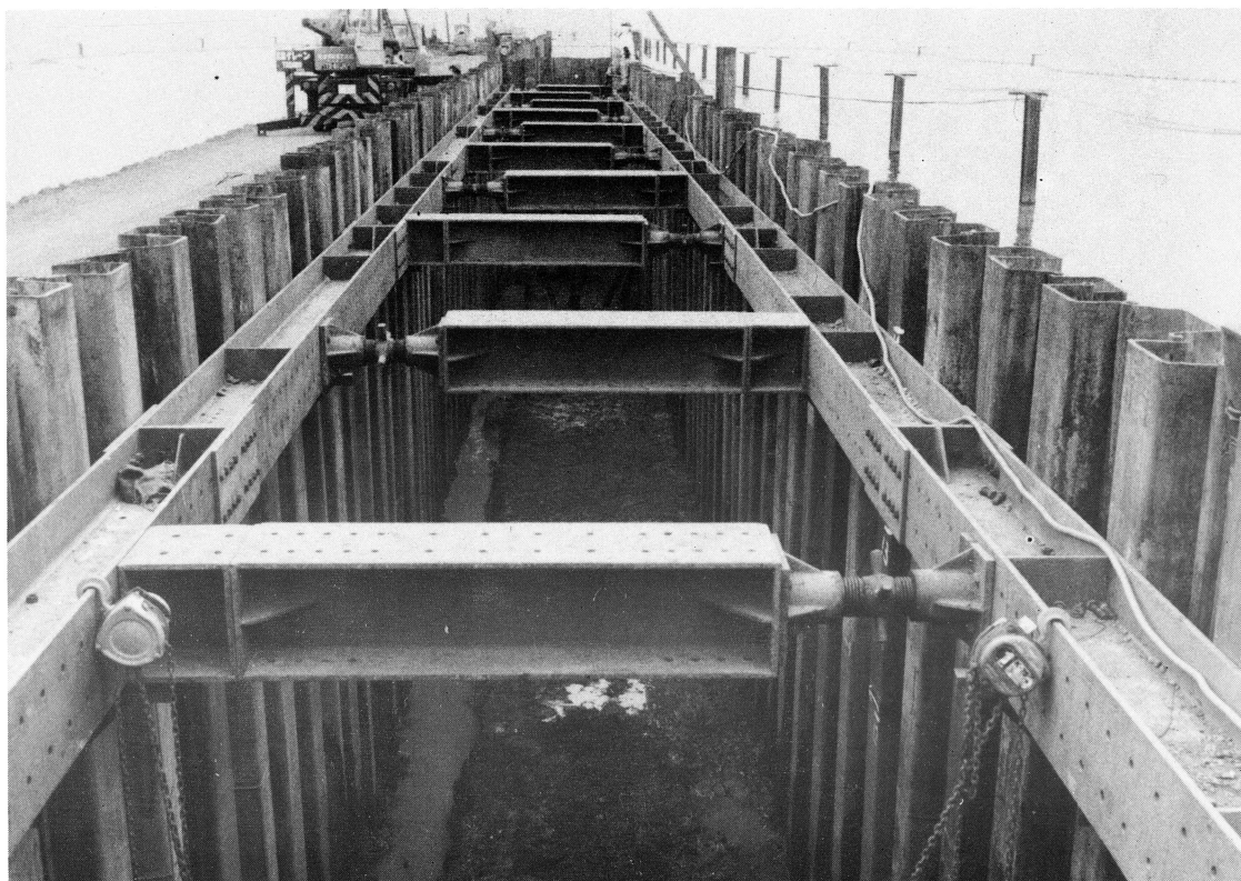
1. レッカー、小型バックホーによる掘削
