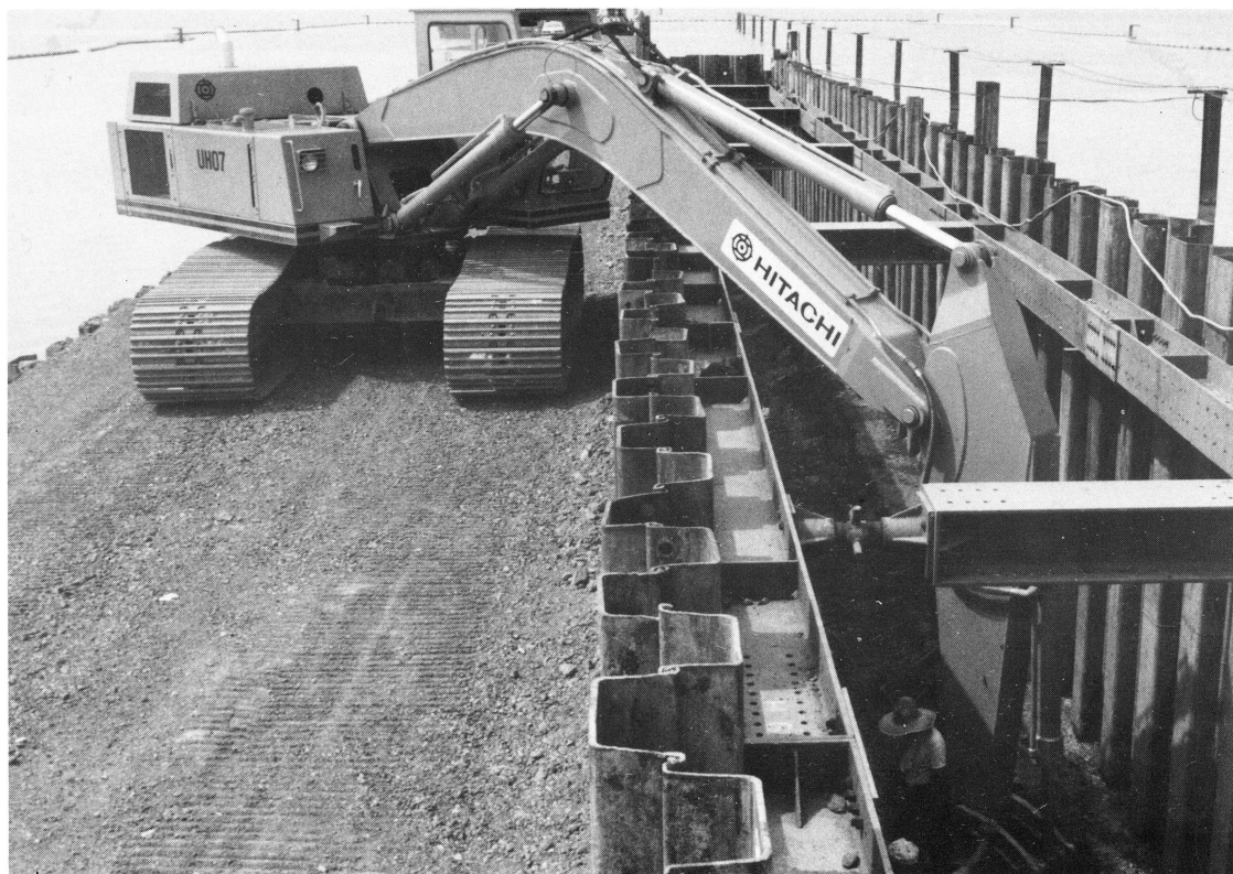
1. 大型バックホーによる掘削
