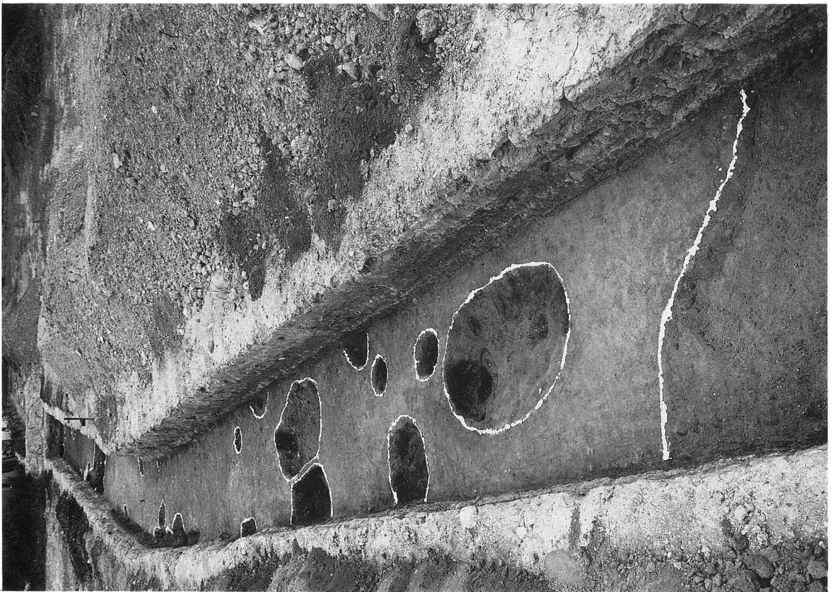
(2) T-4 全景 (南より)
