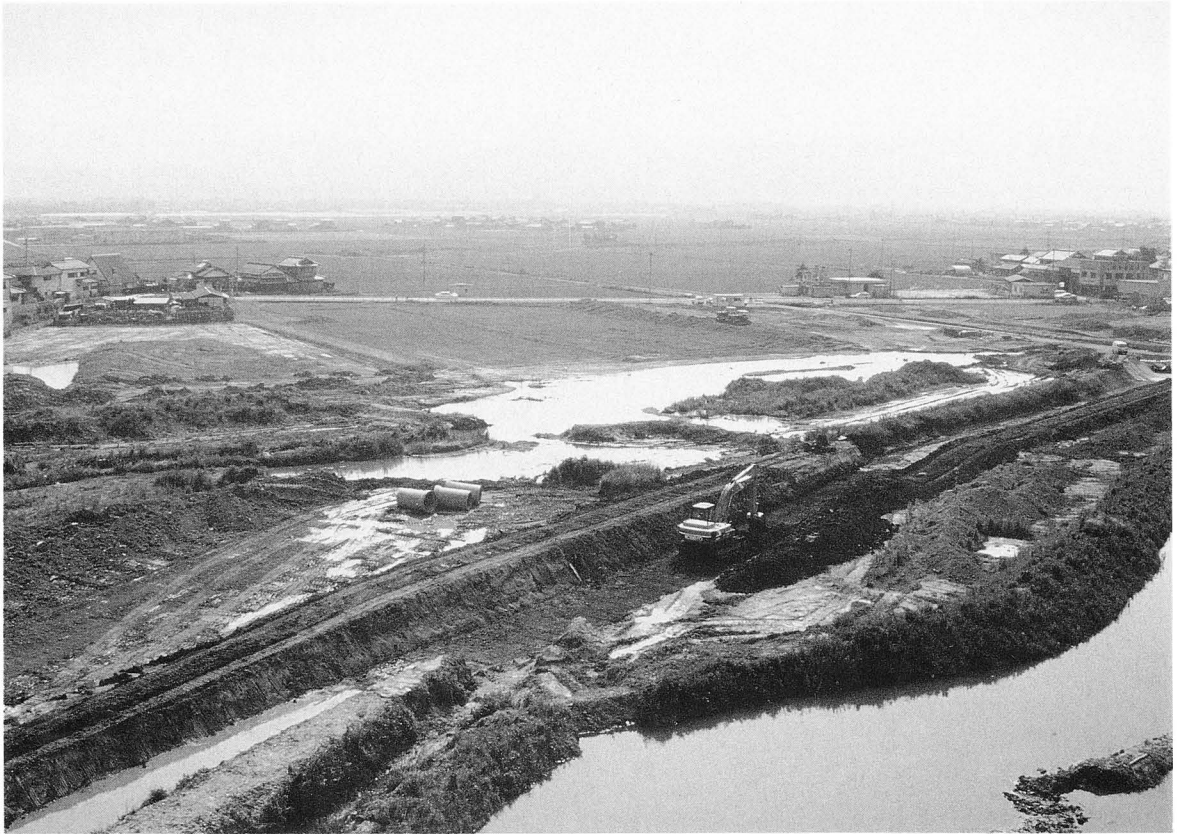
(1) 調査地遠景 (東より)
