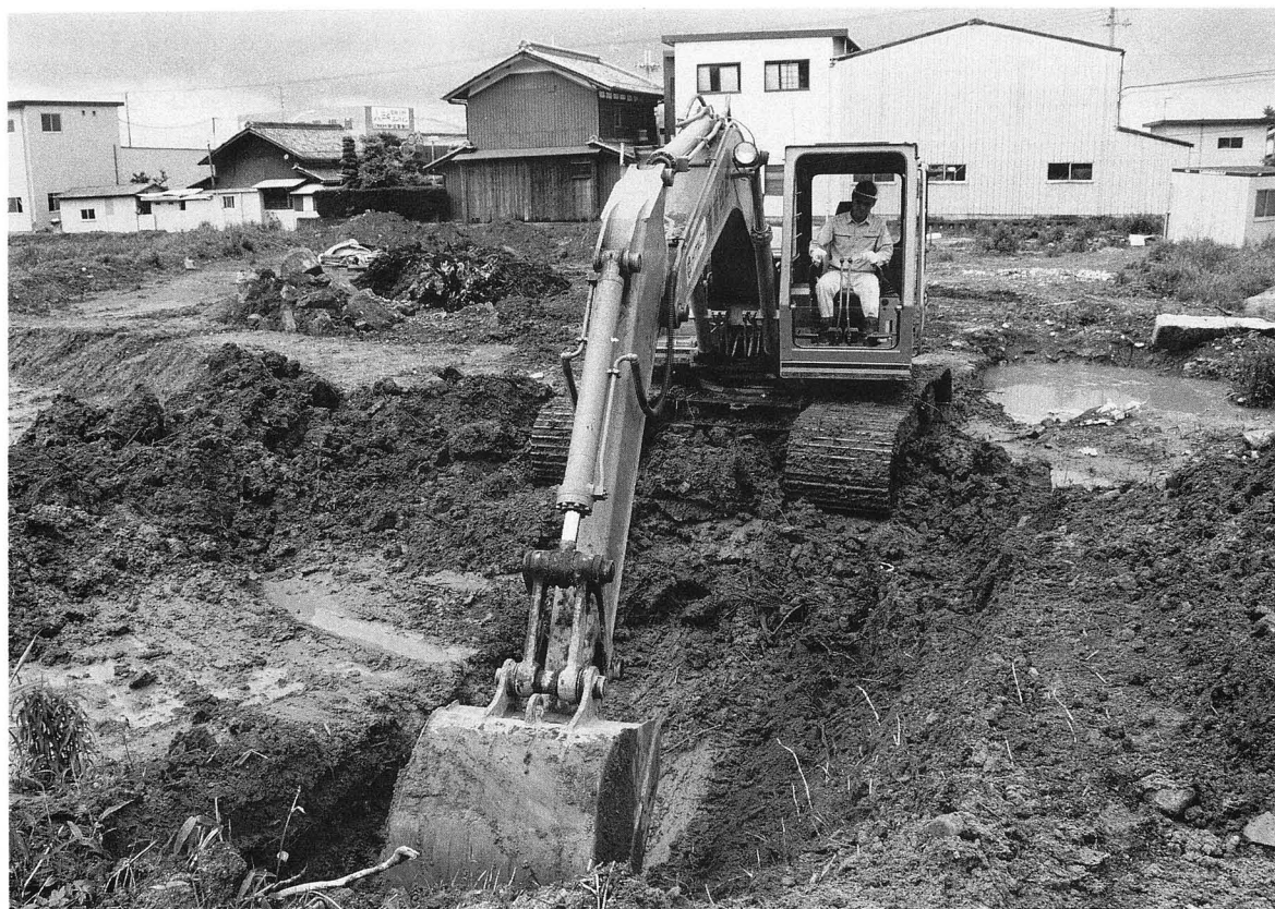
(2) T-2 表土除去 (北より)
