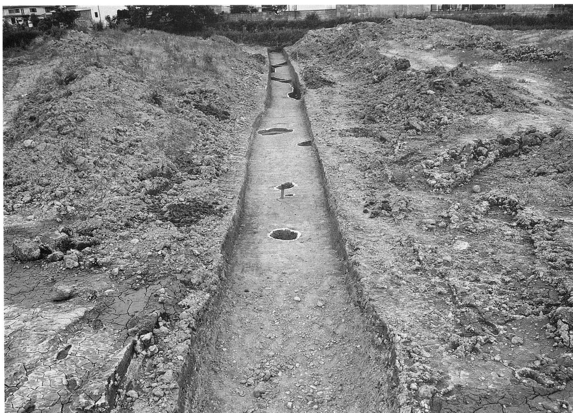
(2) T-5 全景 (南より)
