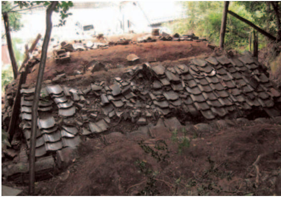
煙出上面の屋根瓦
