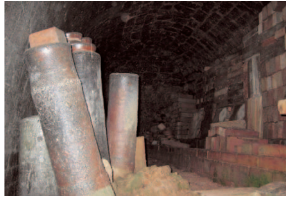
9房内部調査前
