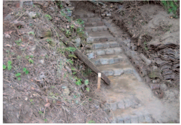
9房作業場と階段
