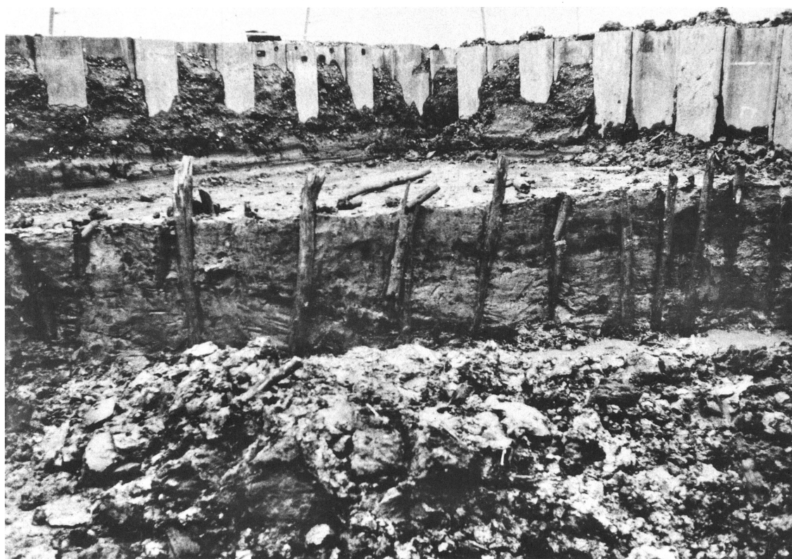
2号桥梁杭列出土状况
