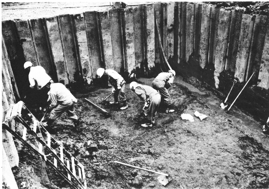
2号橋梁調査風景
