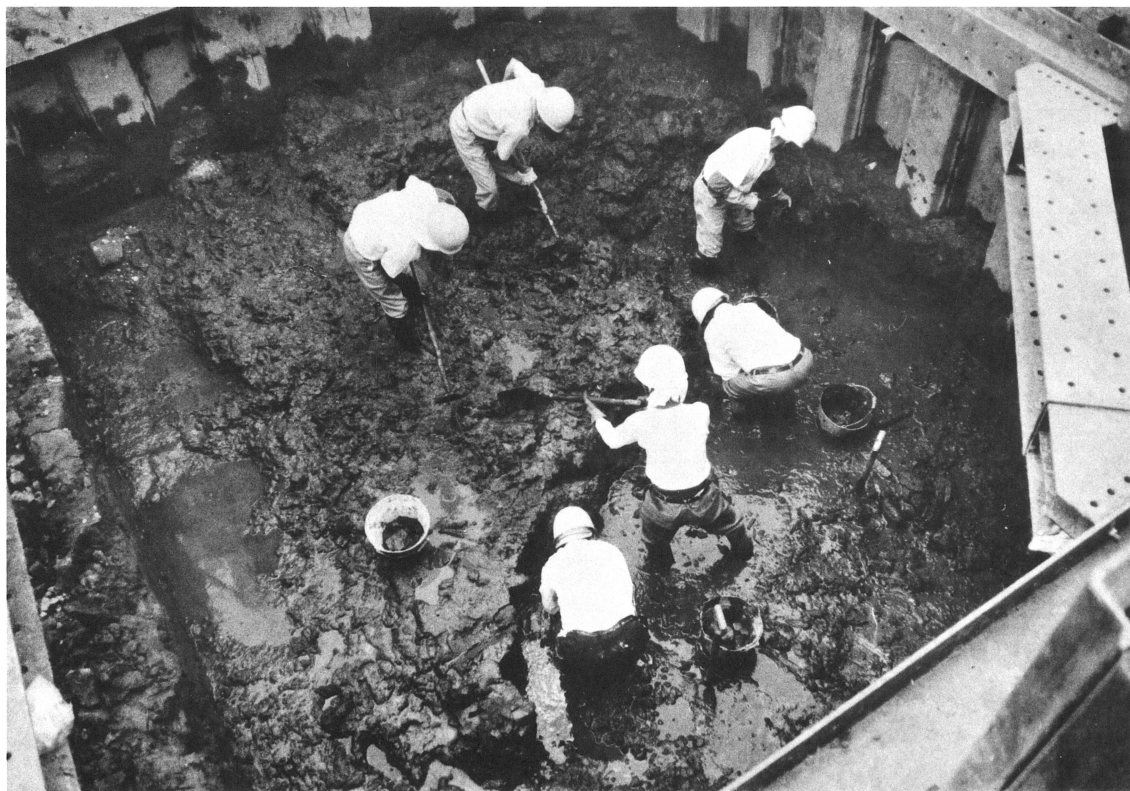
3号橋梁調査風景
