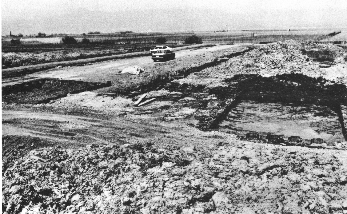
2号橋梁調査前全景（上流より琵琶湖を望む）
