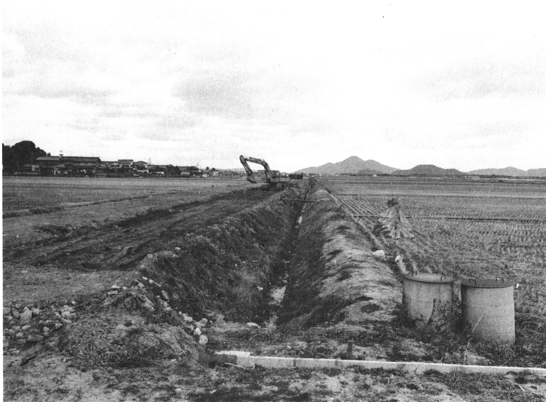
H04・H05埋めもどし状況（南より）
