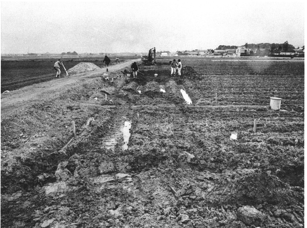
試掘調査風景（北より）
