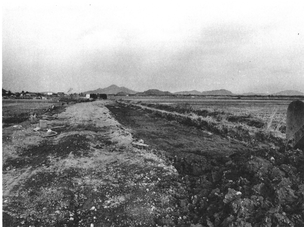
H04埋めもどし状況（南より）
