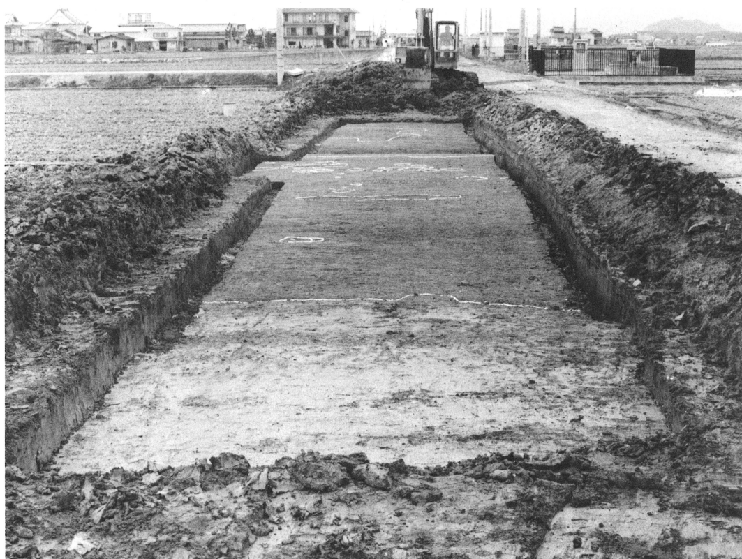
H06全景（南より）
