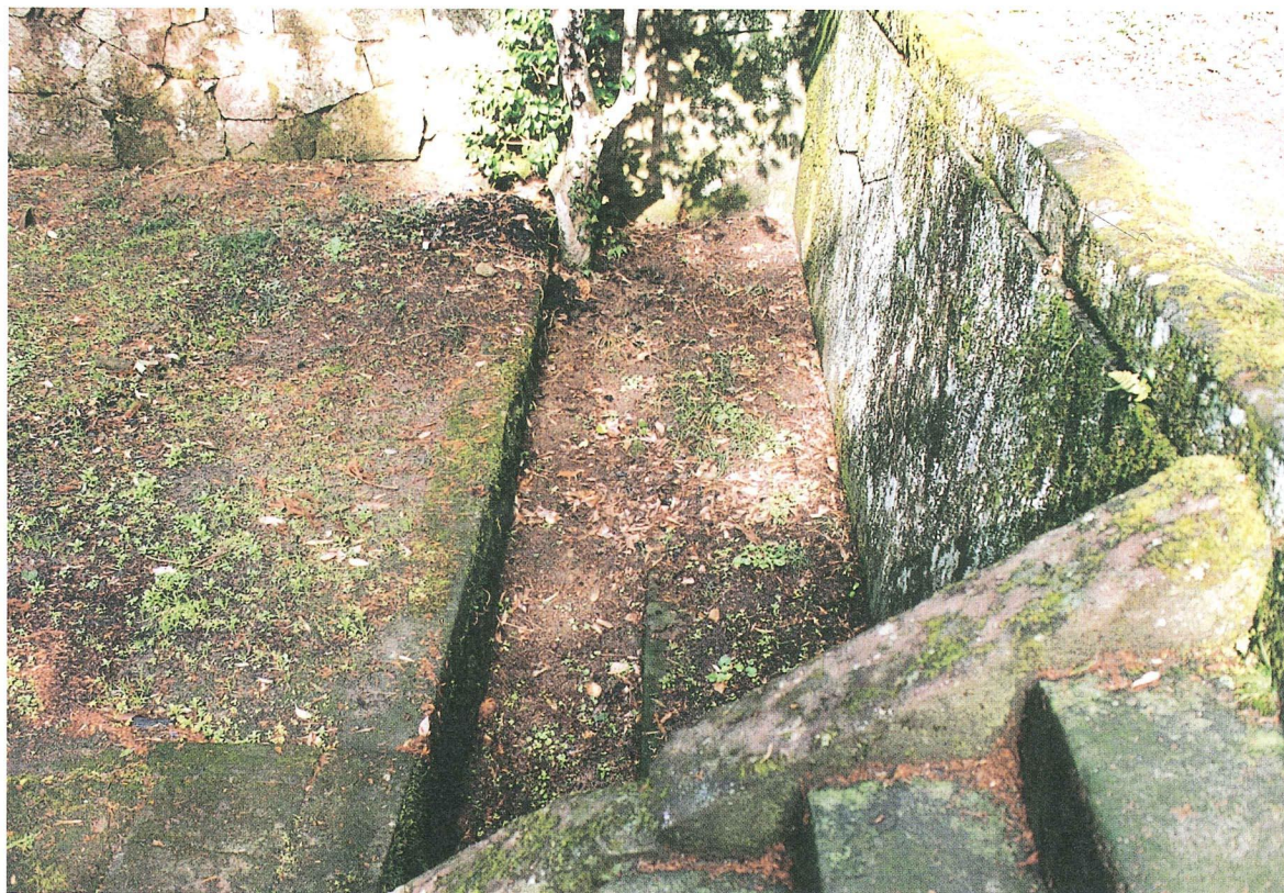
既設排水路(八代廟所前)
