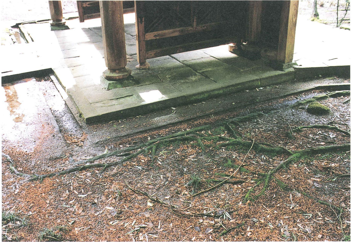
既設排水路(八代廟門付近)
