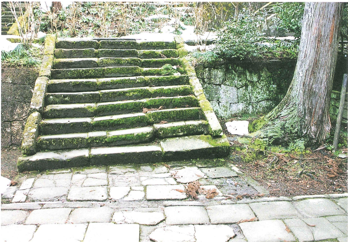
同 上(五代廟所入口付近)
