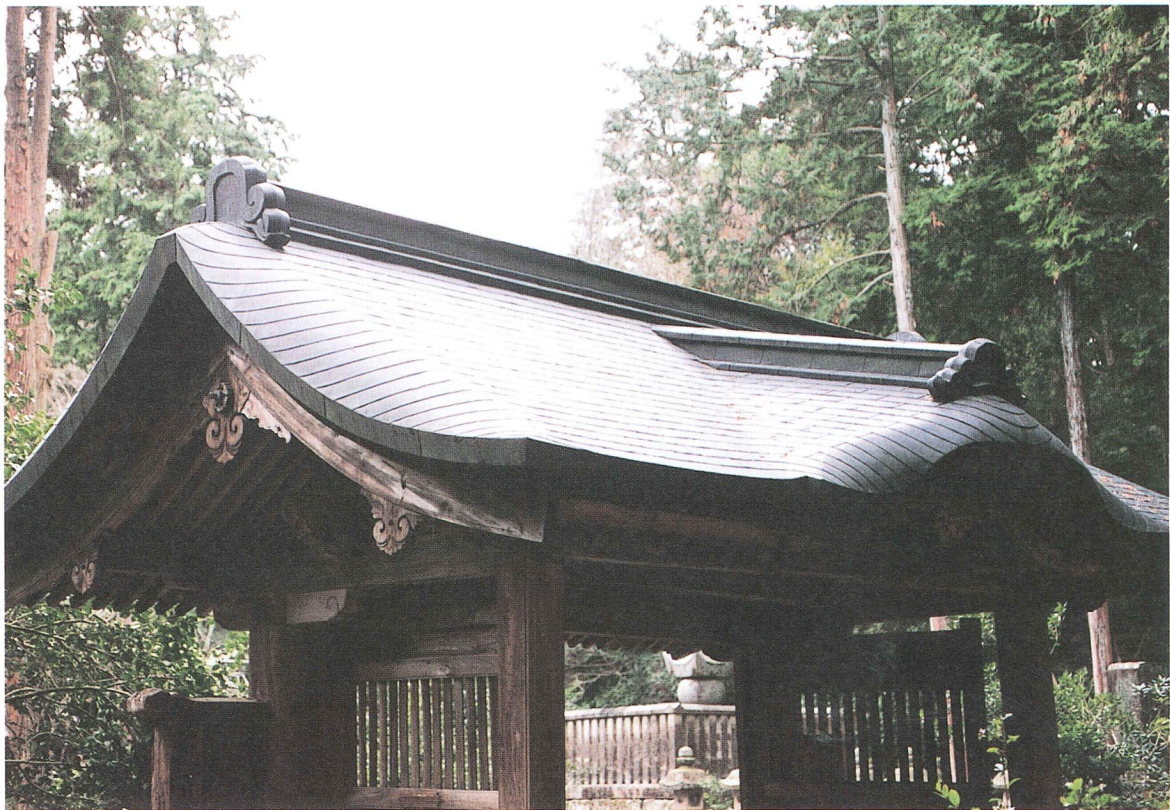
廟門屋根(銅板葺)
