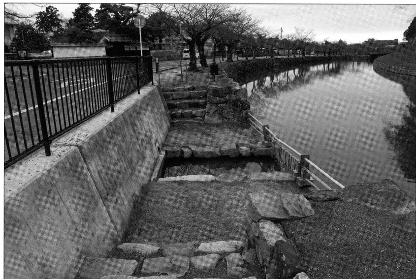
保存修理を完了した広小路御舟入石垣
