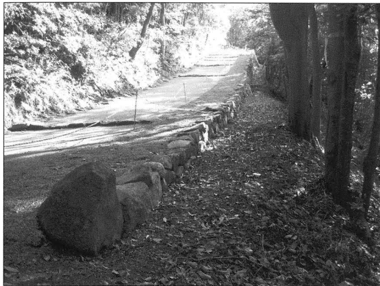
保存修理が完了した山崎山道西側石垣
