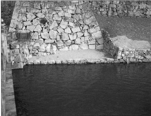
保存修理を完了した大手門橋内詰南側石垣
