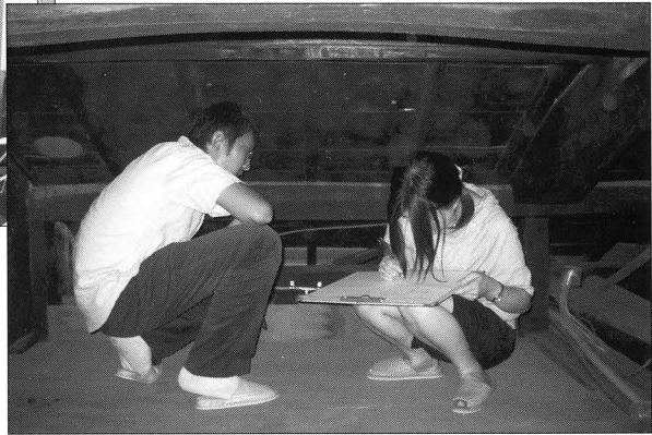
建造物実測調査
