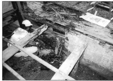
敷板の腐朽
