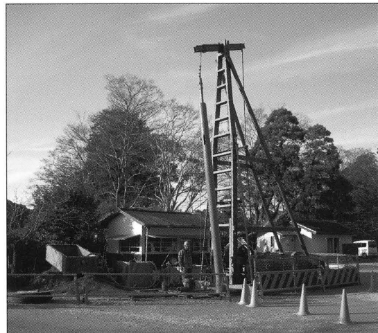
さく井工事状況
