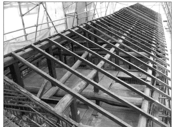
解体修理で小屋組みが露呈した旧池田屋敷長屋門
