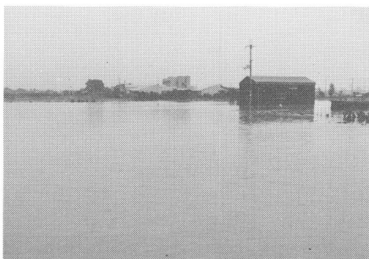
写真1 唐古・鍵遺跡の水没(正面建物第3次調査地) (国道から東方を望む)
