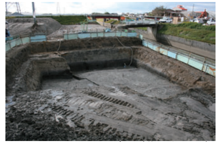
08Ab 区 2 面全景 (北からみる)
