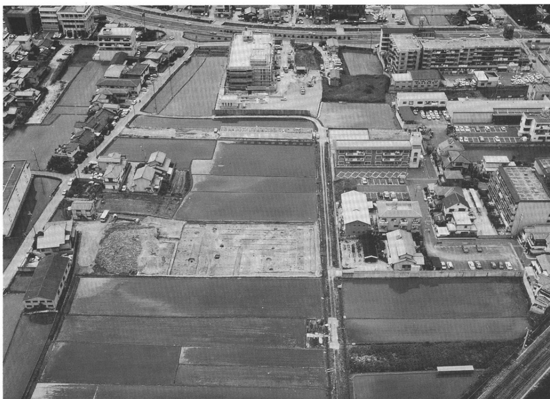
1. 調査地全景(東から)
