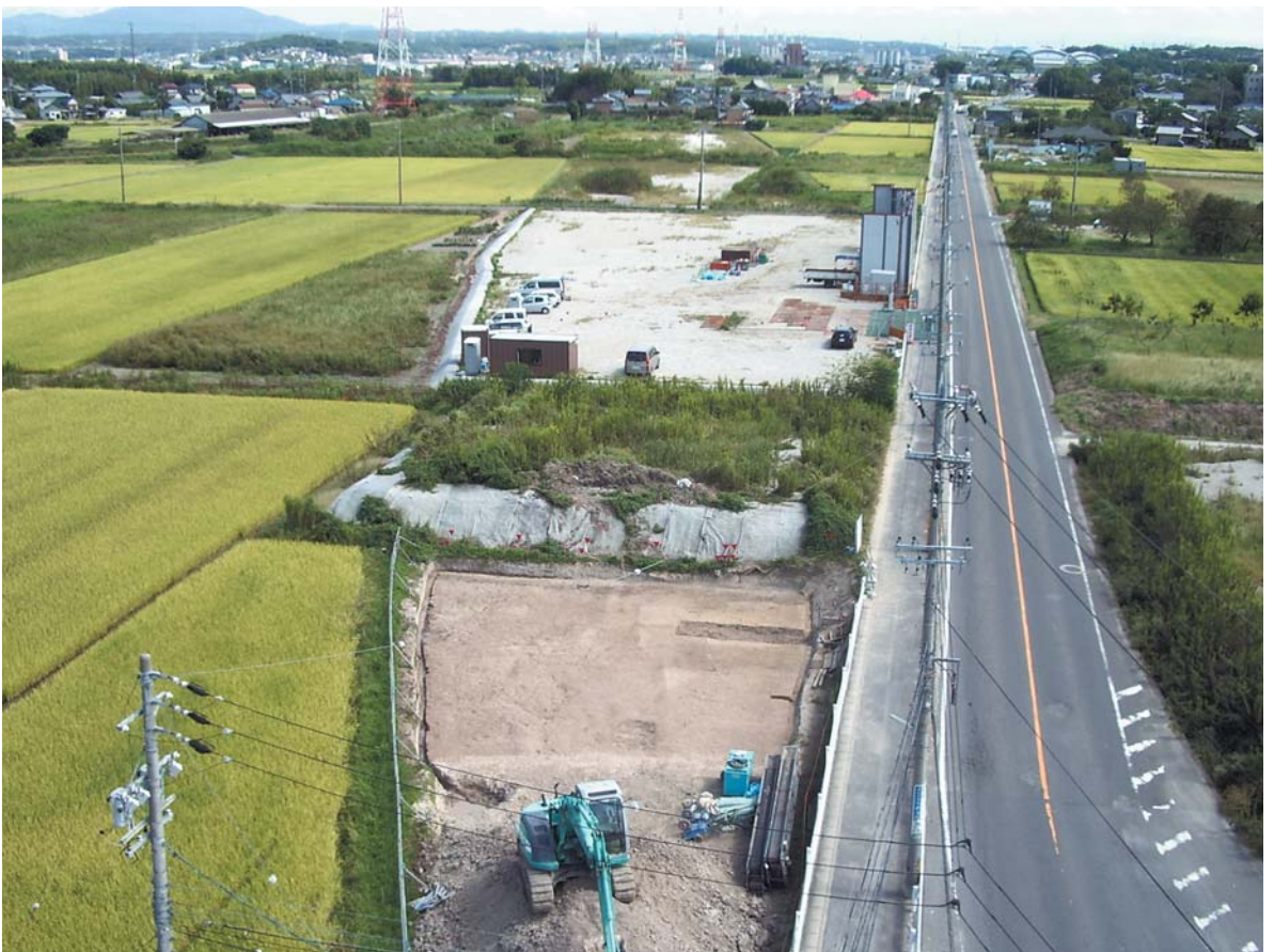
上：三ヶ所交差点東後方から西を望む（遠方は名古屋市街地） 下：三ヶ所交差点上空から東を望む（遠方の市街地は日進市役所周辺）
