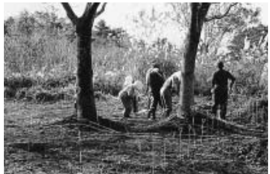
ボーリング調査 調査風景
