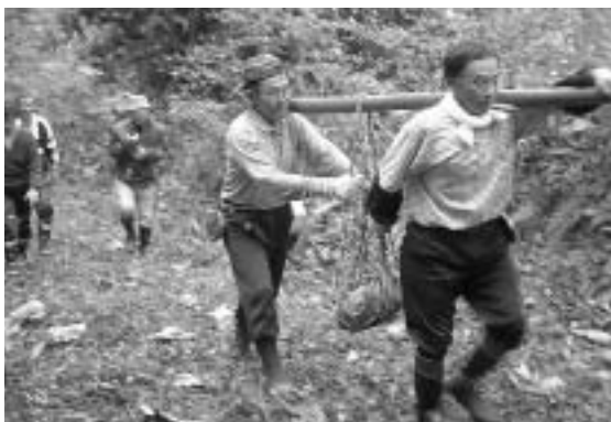
モッコによる運搬状況
