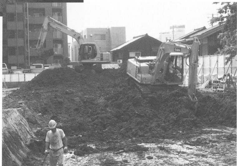
東側調査区表土除去作業風景
