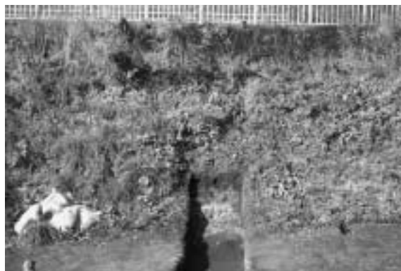
27ライン トレンチ
