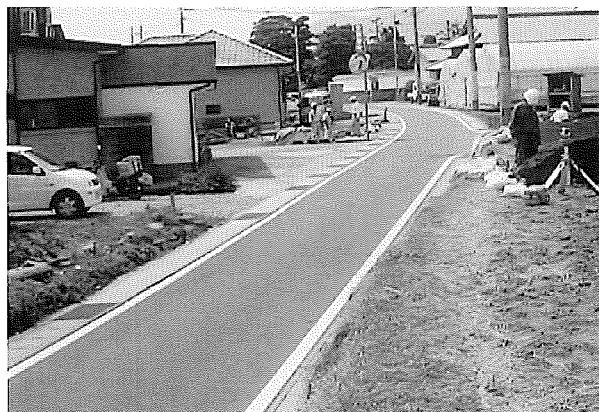
作業風景(南から)
