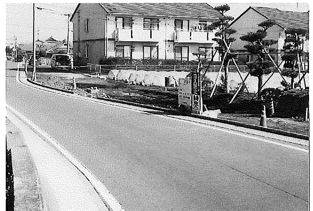
調査区近景 (南から)
