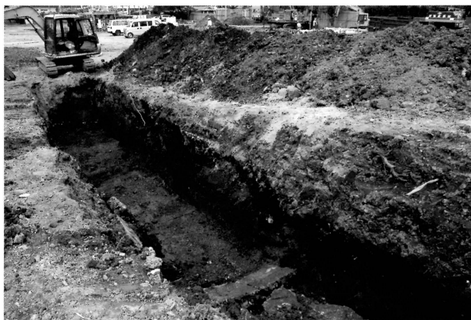
トレンチ掘削状況 (東より)
