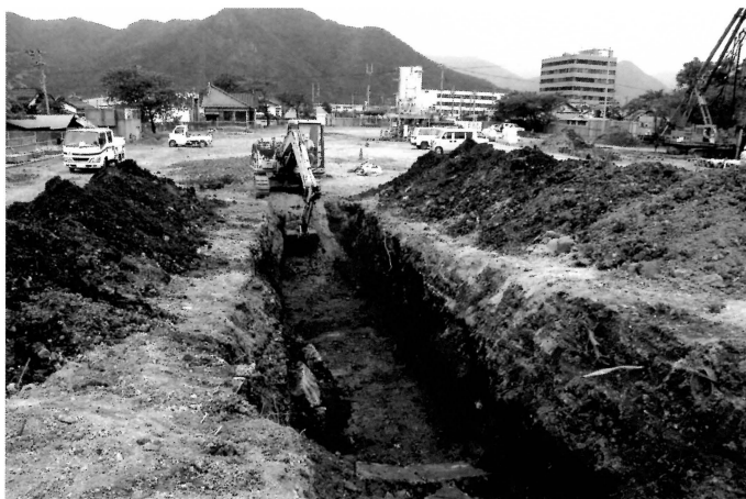
トレンチ検出状況 (東より)
