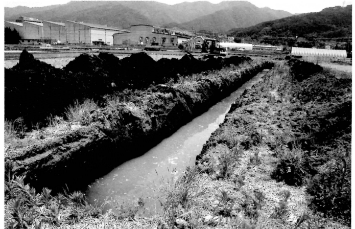
2号トレンチ検出状況 (西より)
