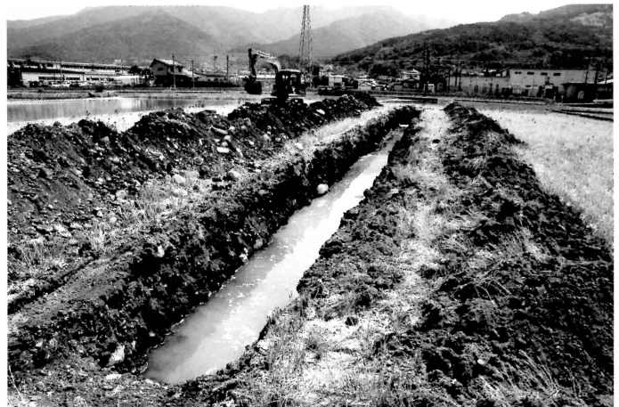
1号トレンチ検出状況 (西より)
