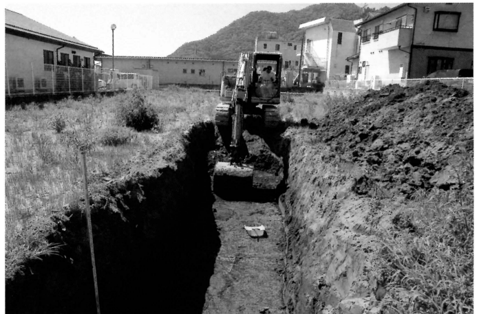
トレンチ掘削状況 (北より)
