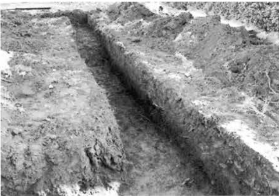
図版 69 基礎東辺 (南西から)
