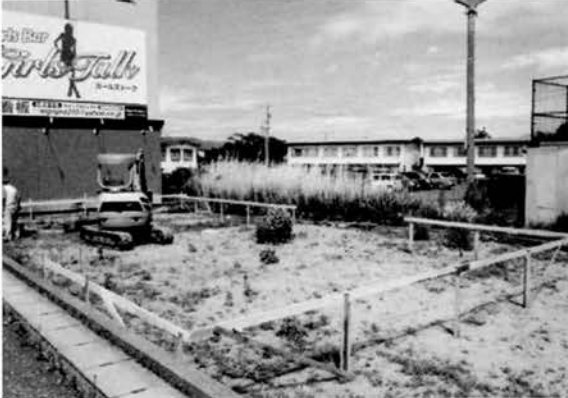
図版 38 調査区全景
