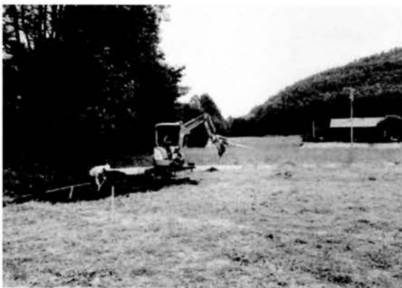
図版 30 調査区全景
