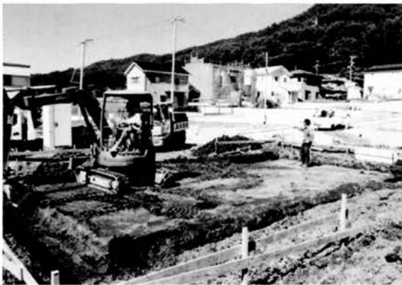
図版 65 調査区全景
