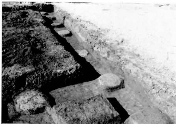
図版 80 掘削状況
