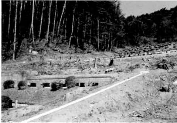
図版 18 調査前全景 1
