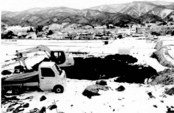
図版 78 調査区全景
