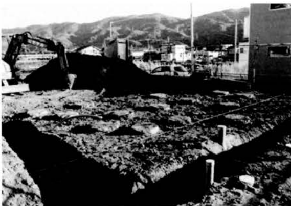
図版 61 調査区全景
