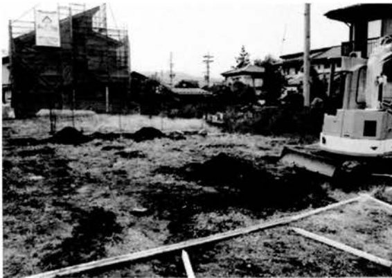
図版 45 調査区全景
