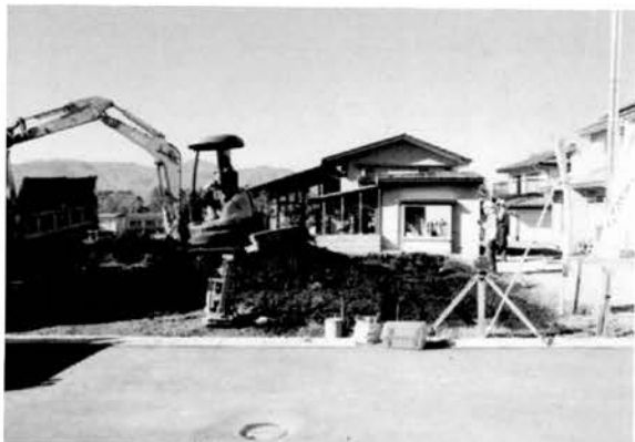
図版 87 調査区全景
