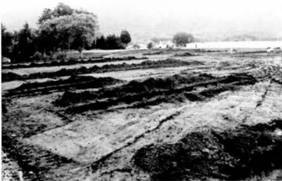
図版 15 調査状況 (北東から)
