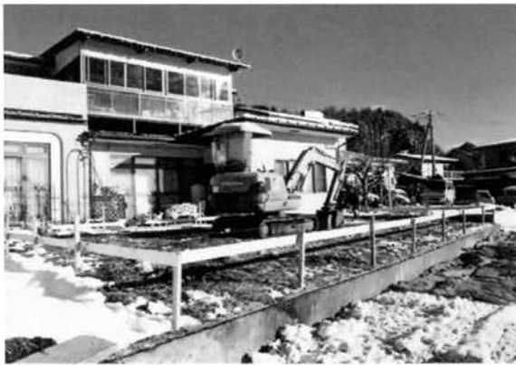
図版80 調査区全景
