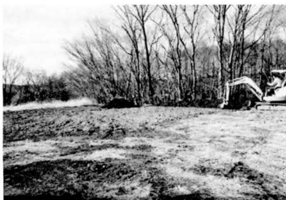
図版 32 調査区全景
