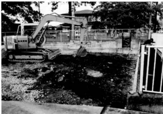
図版 67 調査区全景
