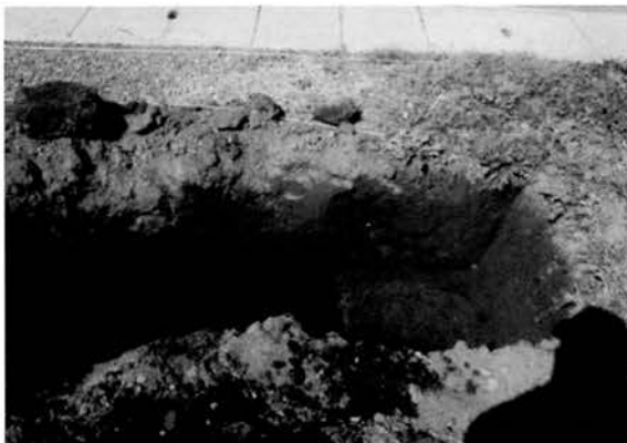
図版 44 2区 (北東から)
