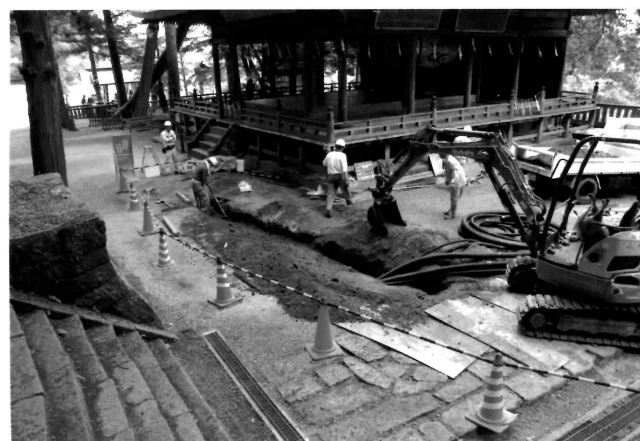
境内掘削工事の様子 (神楽殿前、南東から)
