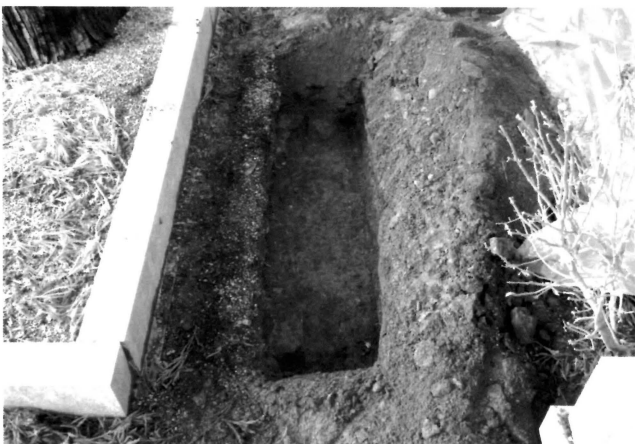
2 トレンチ完掘（南から）
