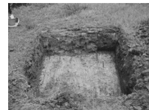
写真26 トレンチ3完掘(W→)
