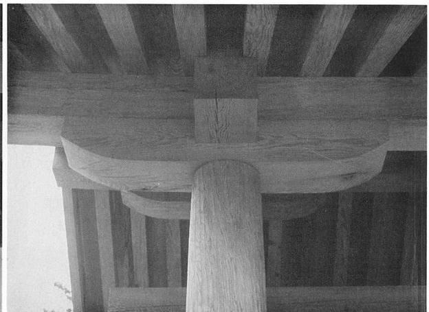
四脚門控柱上部の構造
