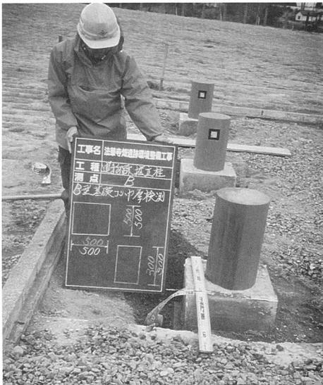
建物表示施設工事（奥の2本、フットライトを設置した掘立柱）
