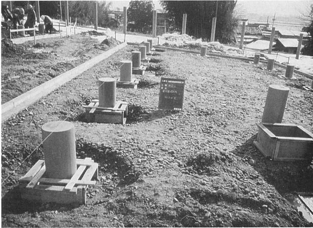
建物表示施設工事（掘立柱設置状況）
