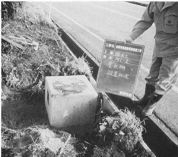
排水工事 (県道側溝に接する集水桝設置状況)
