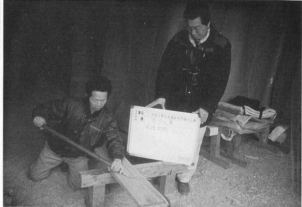
四脚門復元工事（屋根材料加工作業状況）
