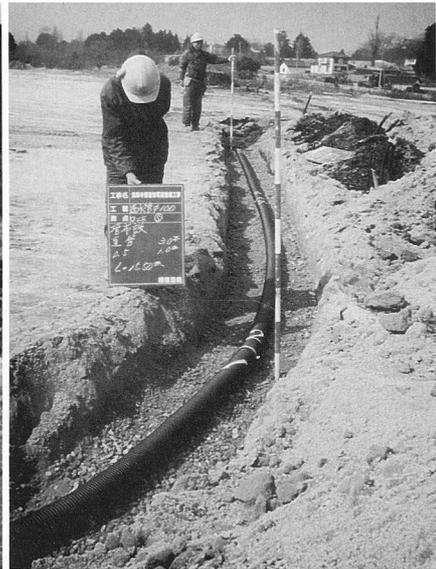
排水工事 (透水管布設状況)
