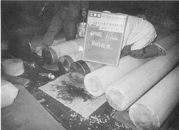
柵列掘立柱加工状況（天端銅板取付け状況）
