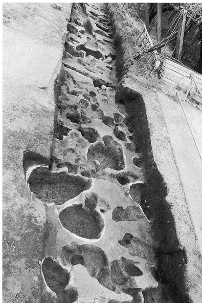
B区（高台部）完掘状況（南から）
