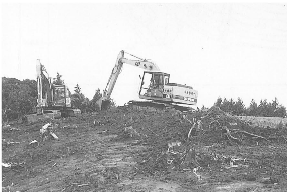
写真① 池ノ谷第2遺跡重機表土剥ぎ作業
