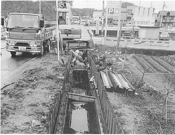
調査風景 東より
