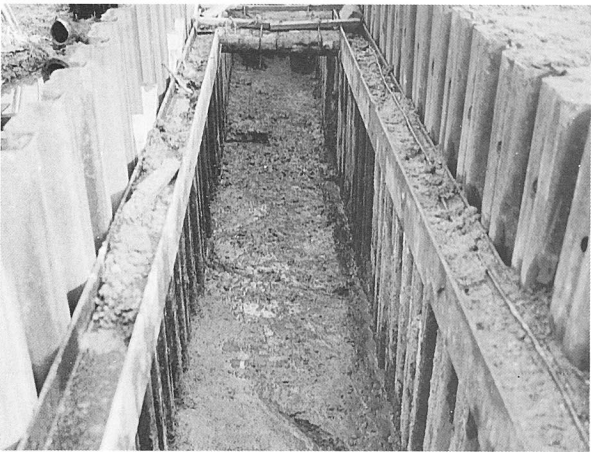
1区完掘 西より
