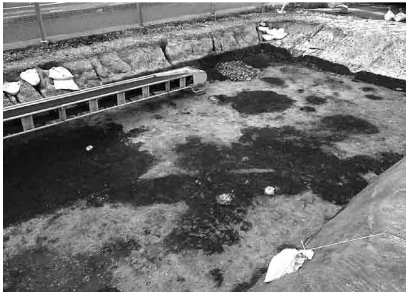
2. 1区-3 東 SE111 周辺遺構検出状況 (北西から)
