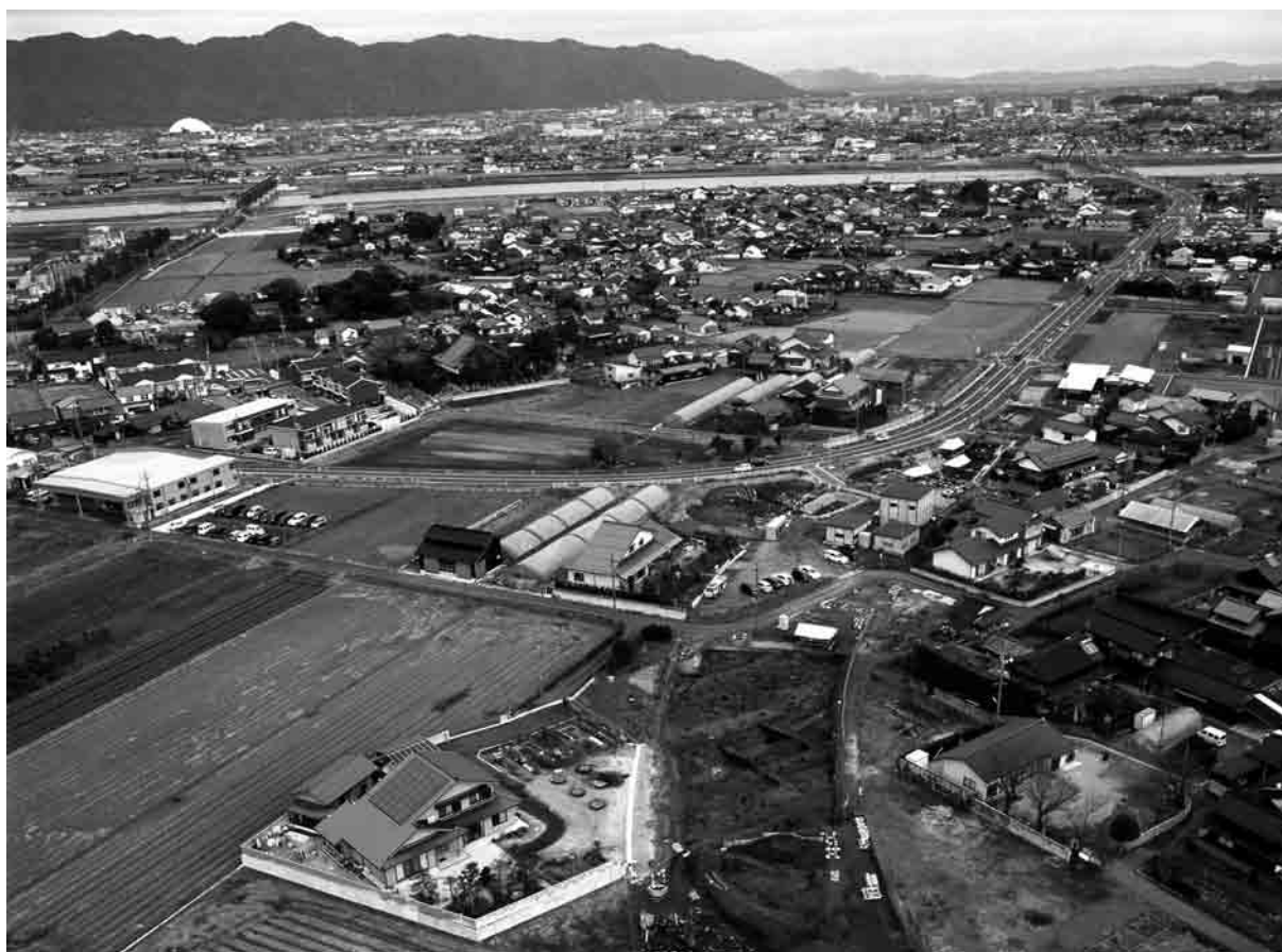
2. 2区空撮（南から）
