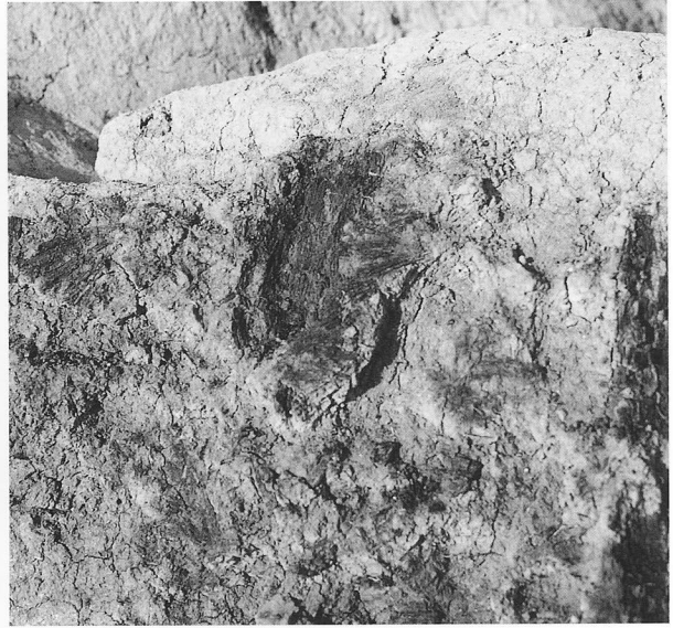
2. 壁面炭化材(W1)検出状況（西から）
