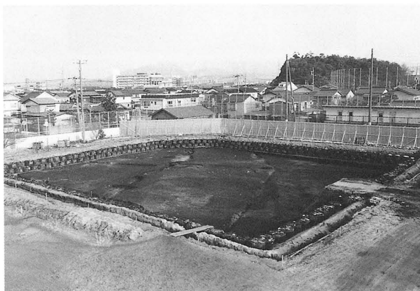
5区 溝全景 (西から)
