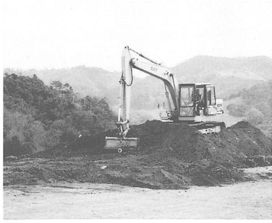
写真1 重機による表土剥ぎ
