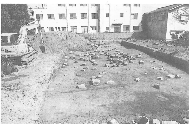
6・礎石建物検出（西より）
