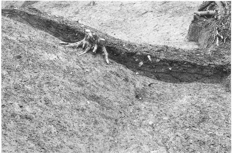
40号墳 北東裾断面 (南東から)
