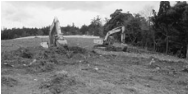
写真1 表土剥ぎ作業風景
