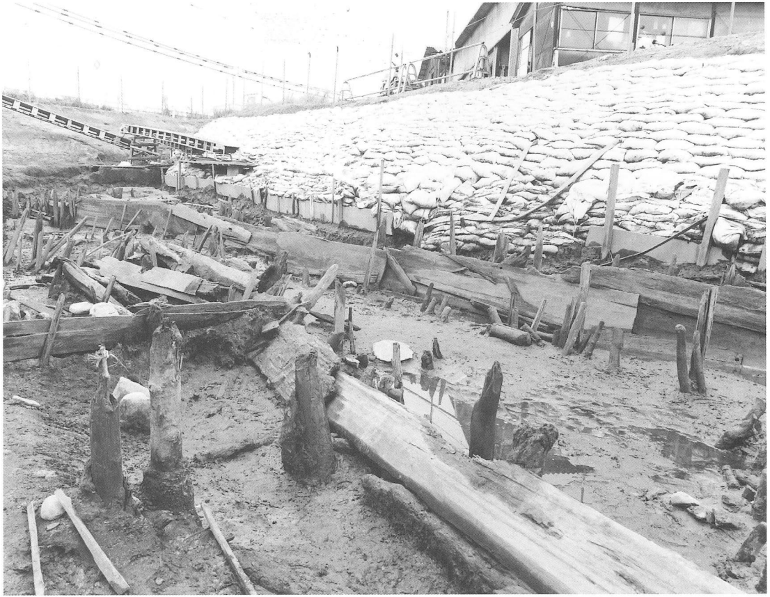
S D27、S A11護岸施設・杭、板材使用（北西から）
