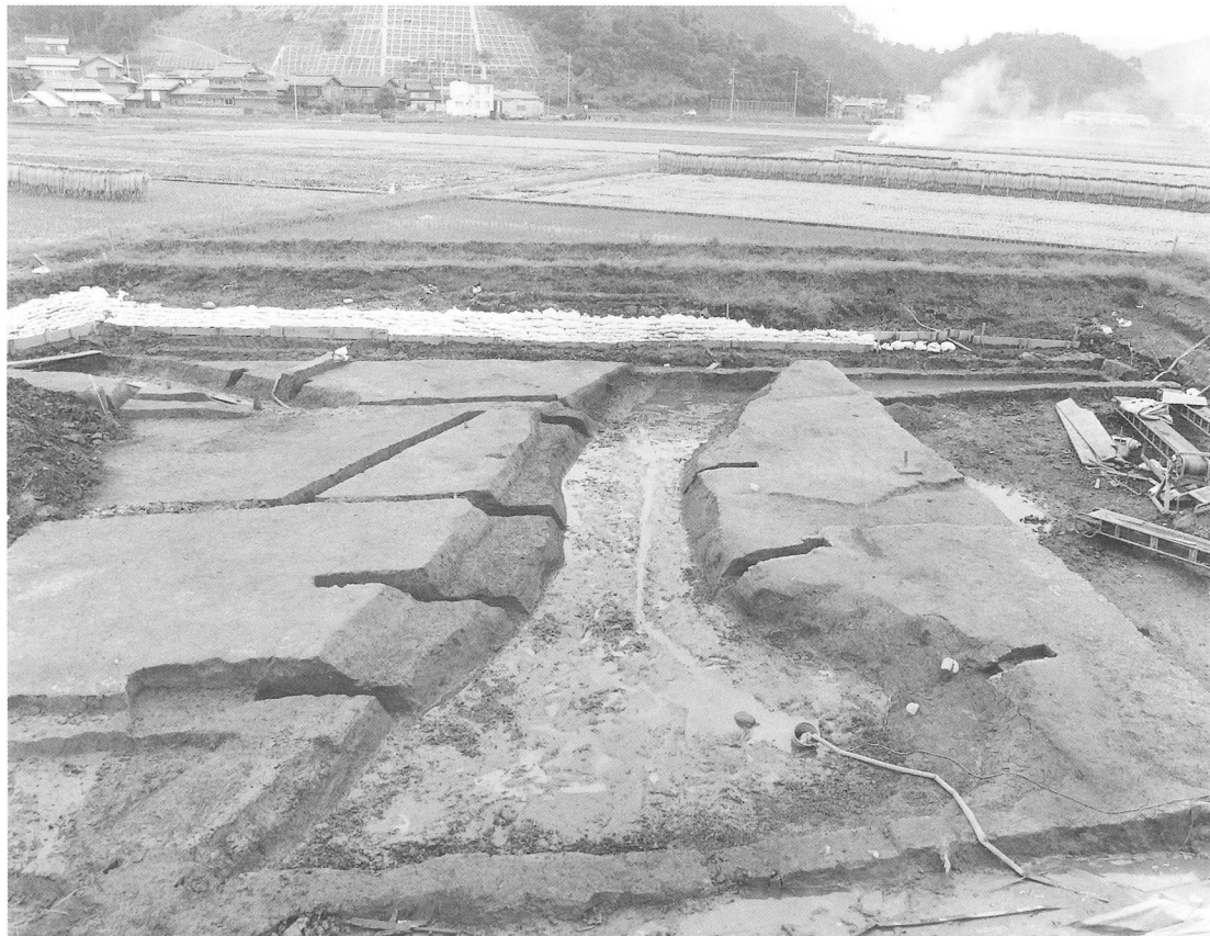
S D11完掘状況（北から）
